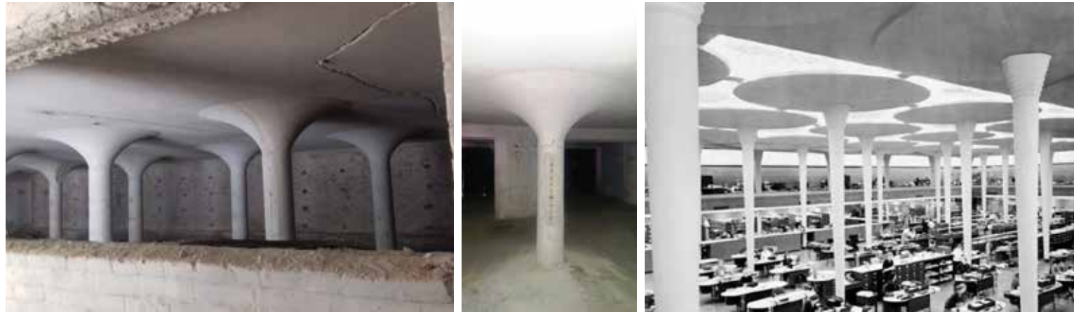
Stalpii (rotunjiți) cu capitel evazat din Parter par inspirați de cei de la Johnson Wax Administration inaugurat de F.L.WRIGHT în 1936
