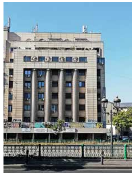
Imobilul de locuit din Splaiul Independenței, vedere din 2021
