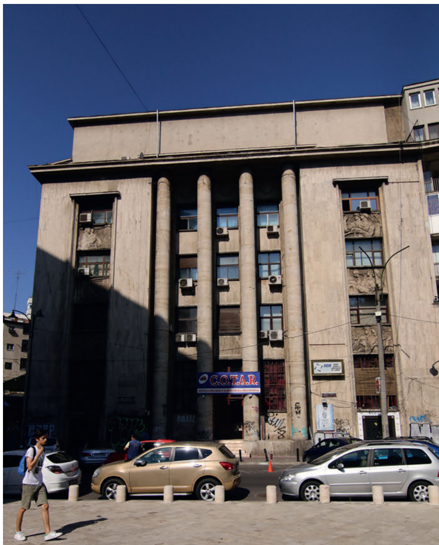
Sediul UGIR (Uniunea Generală a Industriașilor din România) 1938, arh. Constantin Mosinschi, cu altoreliefuri semnate de Mac Constantinescu, Ion Jalea, C. Tureacă
