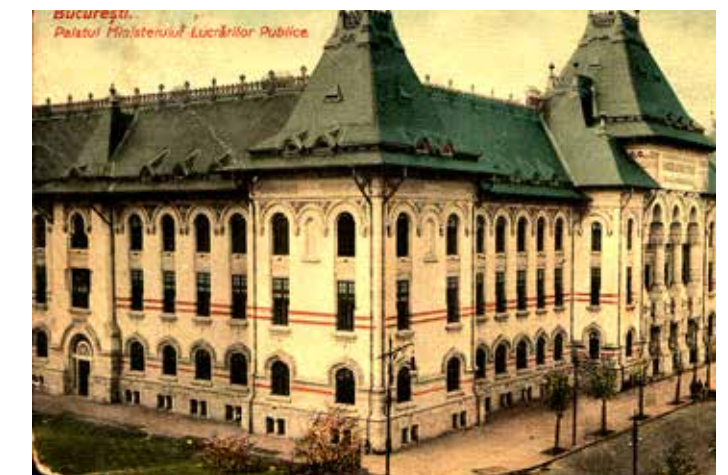
Ministerului Lucrărilor Publice (actuala primărie), București, 1906-1910
