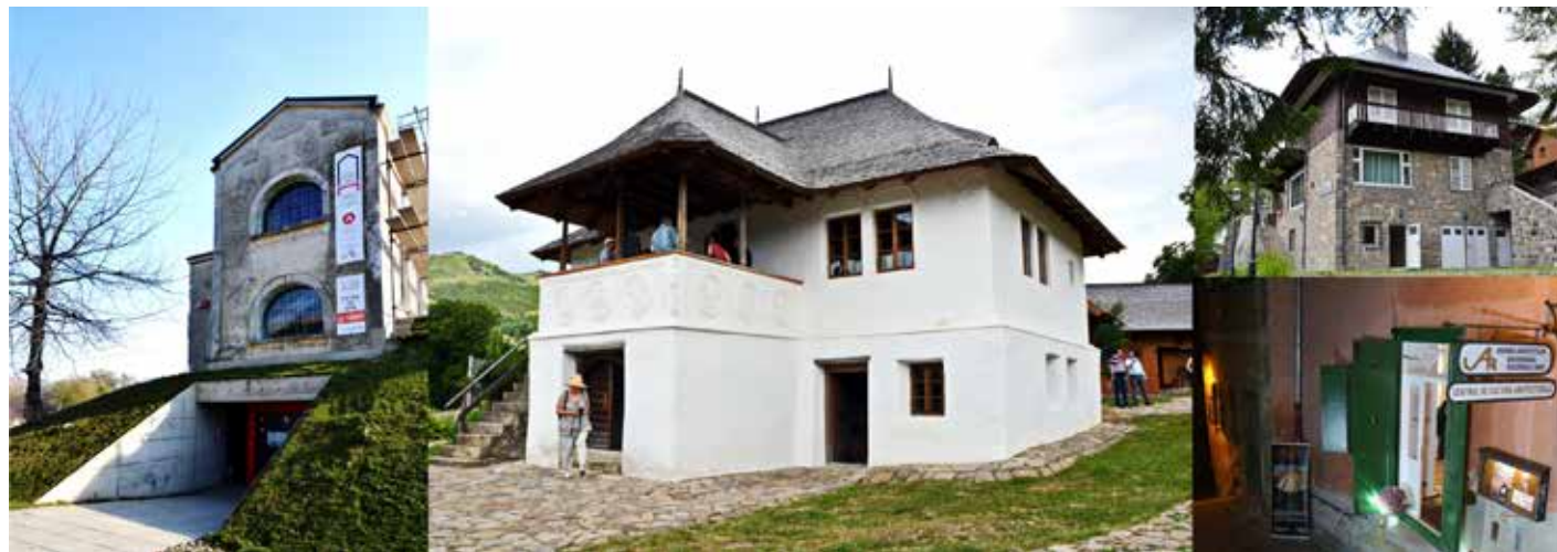
Sedii ale UAR în țară, Uzina de Apă din Suceava (stânga), Casa cu blazoane din Chiojdu, jud. Buzău (mijloc), Casa Arhitecților din Sinaia (dreapta sus), Centrul de Cultură Arhitecturală al UAR de la Sibiu (dreapta jos)
