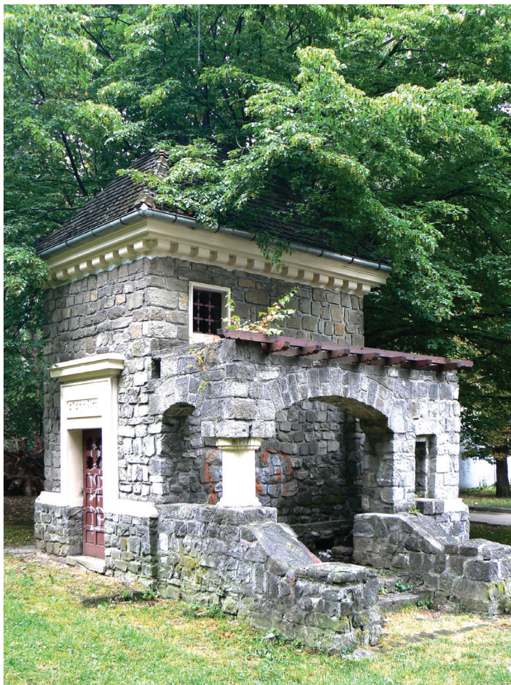
Punct de transformare, Sinaia
