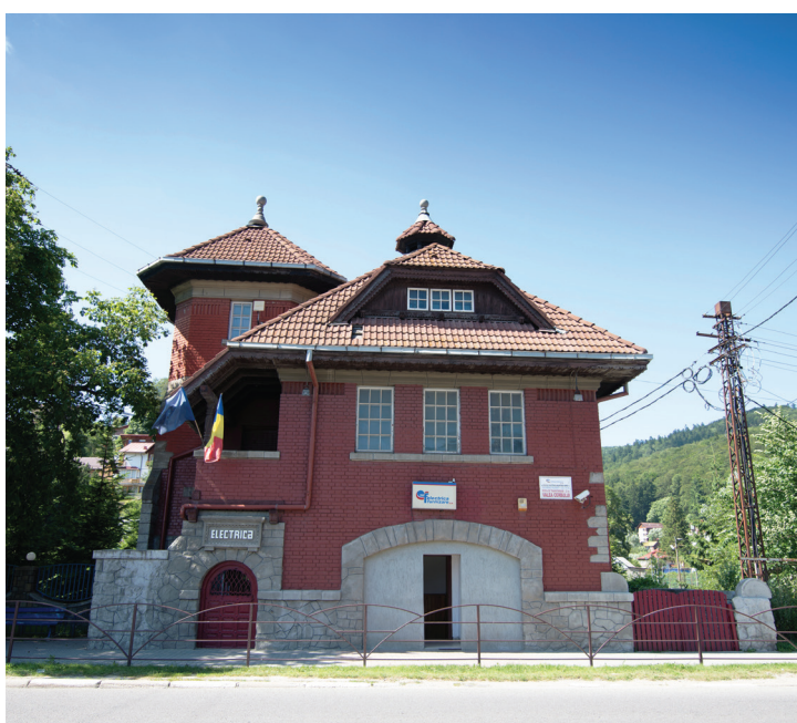
Stație de transformare, Bușteni
