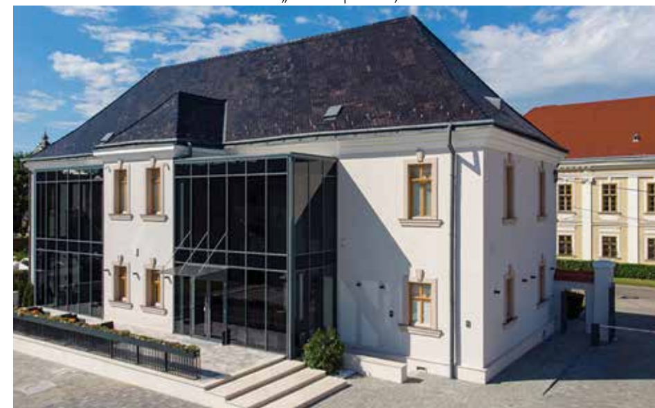
Reabilitare. Conversie. Hotel Dome, Satu Mare
